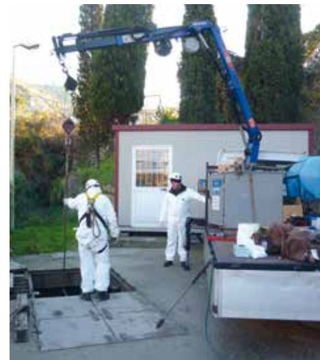
Manutenzione delle pompe e depuratore Villa d'Este, Tivoli
