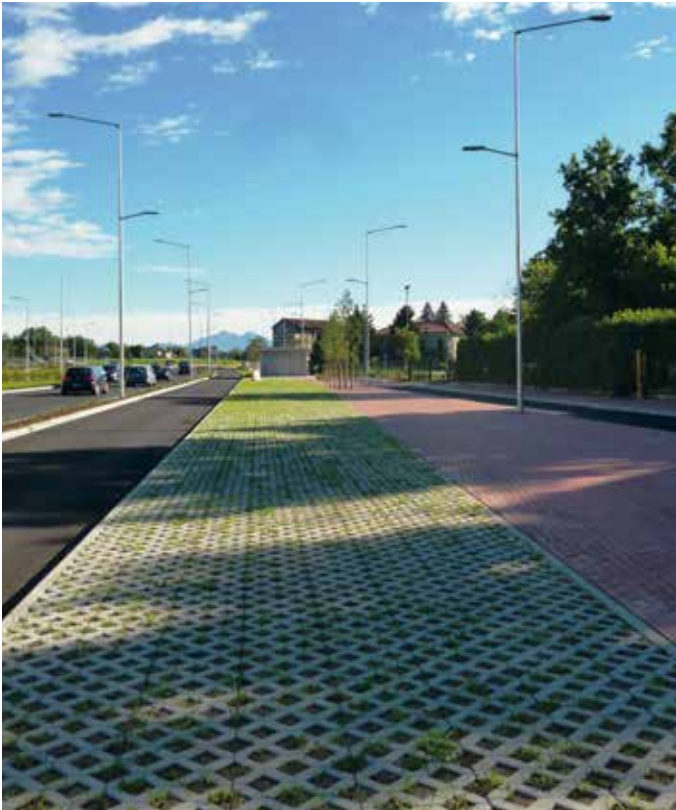
Pavimentazione mista - SS36 Cinisello Balsamo
