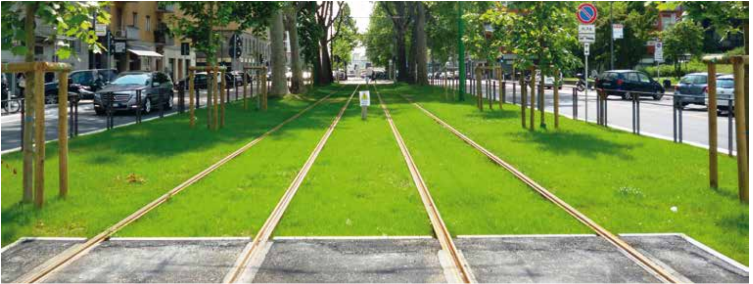
Sistemazione a verde - metropolitana di Milano - stazione Domodossola
