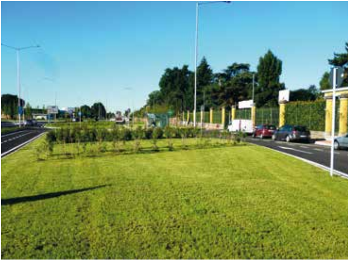
Sistemazione a verde - metropolitana di Milano - stazione Domodossola
